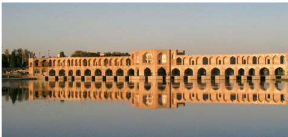
Die berühmte Khaju-Brücke in Isfahan kann dank Schleusen auch als Damm dienen.
