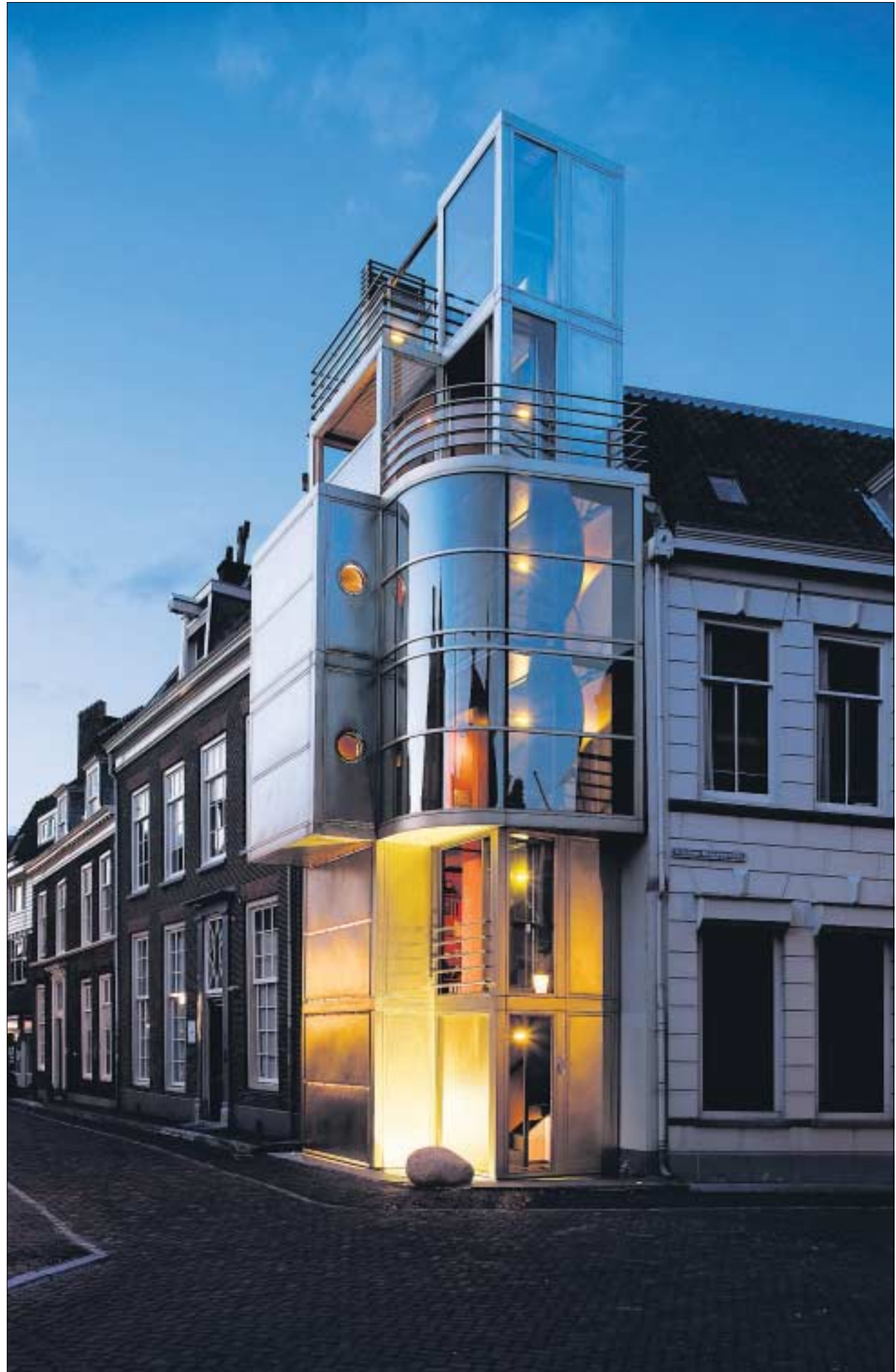
Mit einem gewagten Ansatz fügt sich dieses Stadthaus in Utrecht (Niederlande) in die gewachsene Struktur des Quartiers.
